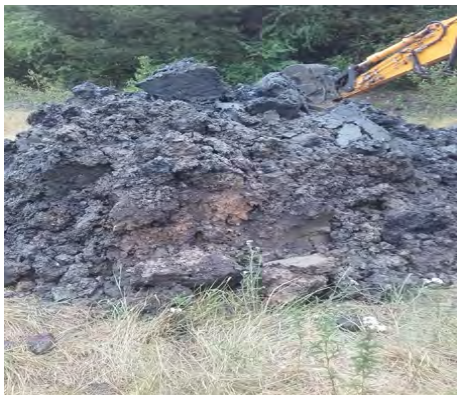
PMD (Terres excavées)
