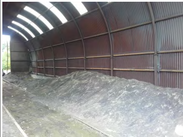
Photographie 17 : Vue de l'intérieur du hangar
