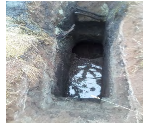
PME (Fond de fouille)
