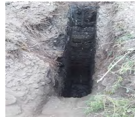
PMB (Fond de fouille)
