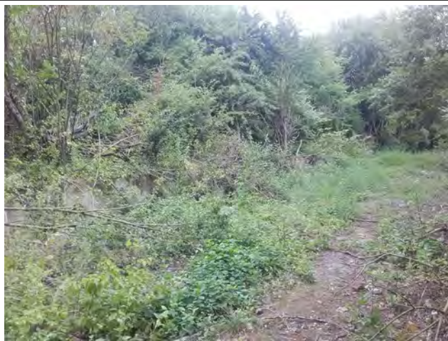
Photographie 19 : Vue générale de l'état de la partie C
