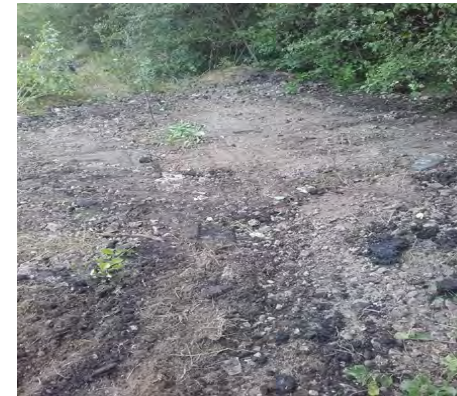
PMB (Fouille rebouchée)
