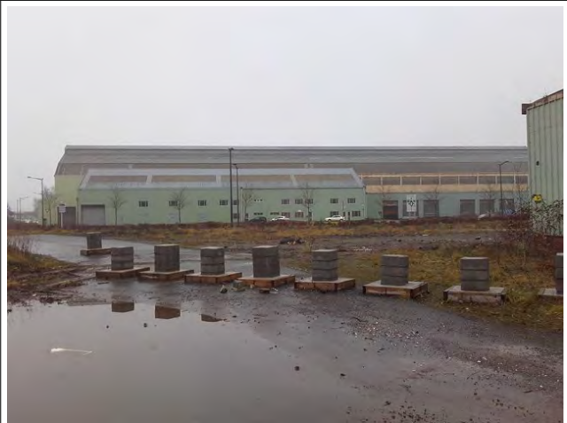
Photographie 2 : Blocs béton anti-intrusion, Nord du bâtiment
