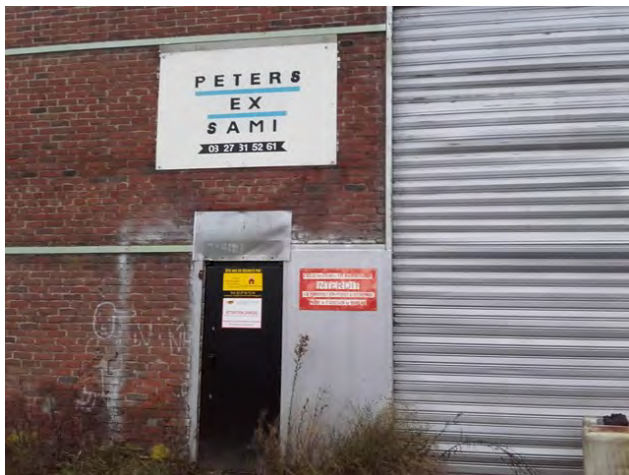
Photographie 3 : Sécurisation du bâtiment
