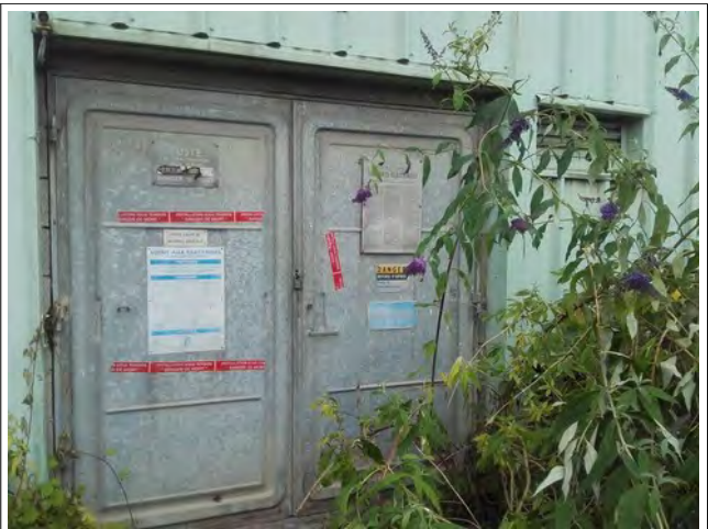
Photographie 10 : Transformateur électrique à l'angle Nord-Est du bâtiment
