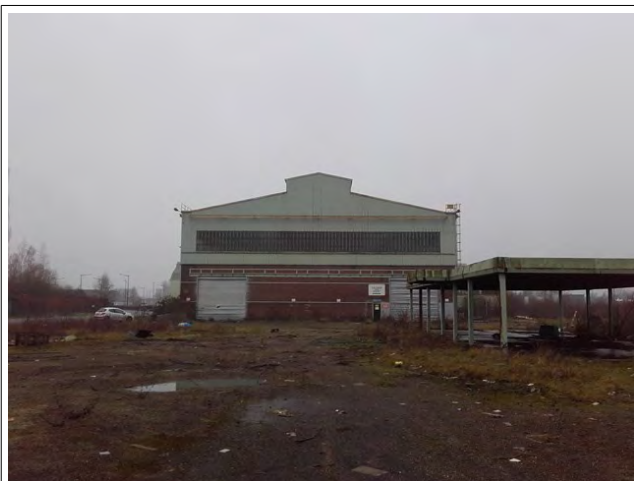
Photographie 13 : Façade Sud du bâtiment de la partie A et ancien bâtiment dégradé
