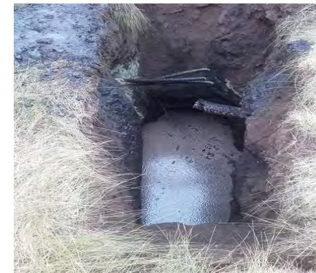
PMF (Fond de fouille)
