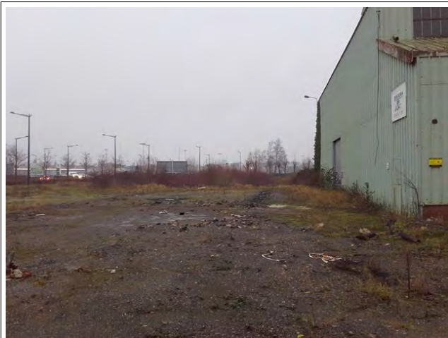
Photographie 5 : Vue du bâtiment principal – façade Nord
