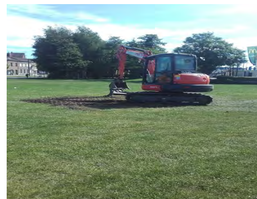
PMD (Fouille rebouchée)
