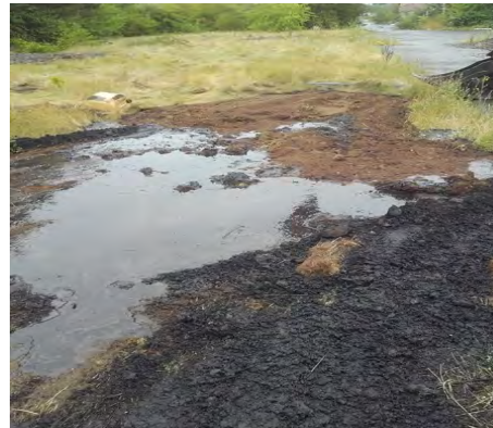
PME (Fouille rebouchée)
