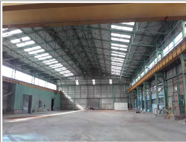
Photographie 11 : Vue générale de l'intérieur du bâtiment
