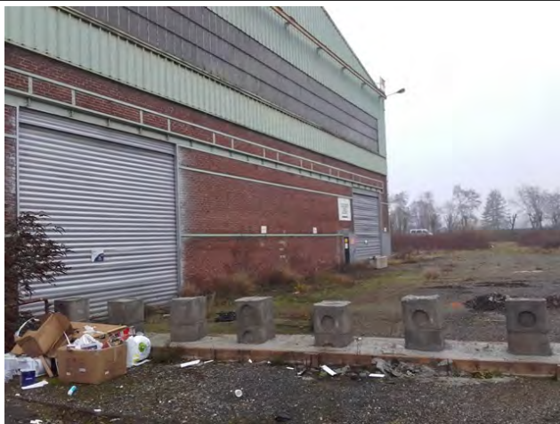
Photographie 1 : Blocs béton anti-intrusion, Sud du bâtiment
