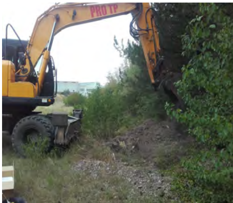
PMB (Localisation de la fouille)
