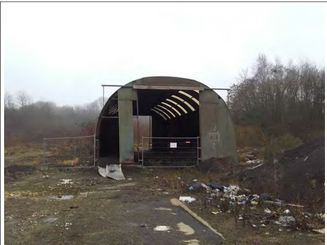
Photographie 16 : Hangar implanté sur les voies de chemin de fer
