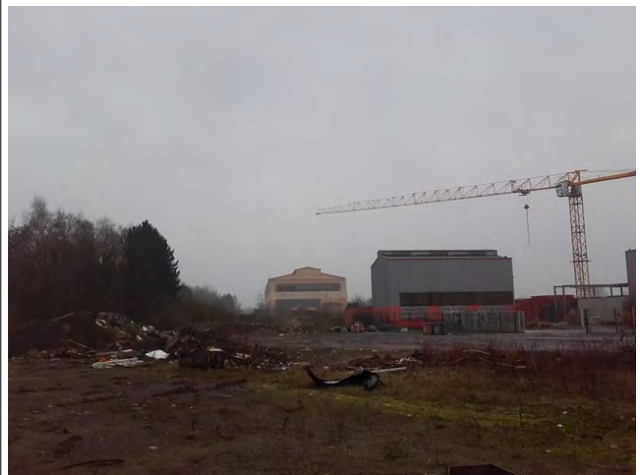
Photographie 4 : Tas de matériaux et déchets limitant l'accès, à l'Ouest
