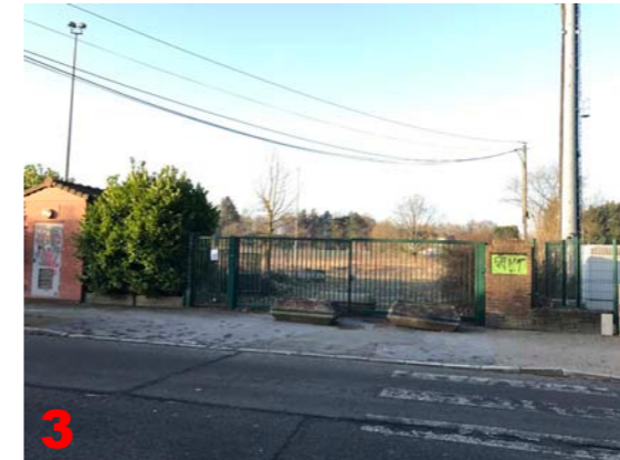
3 Photo de l'entrée actuelle du site 14/02/17
