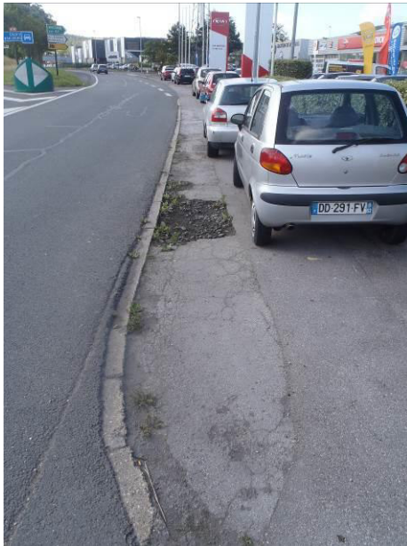
Photo 4 : Stationnements sauvages observés sur la zone industrielle
