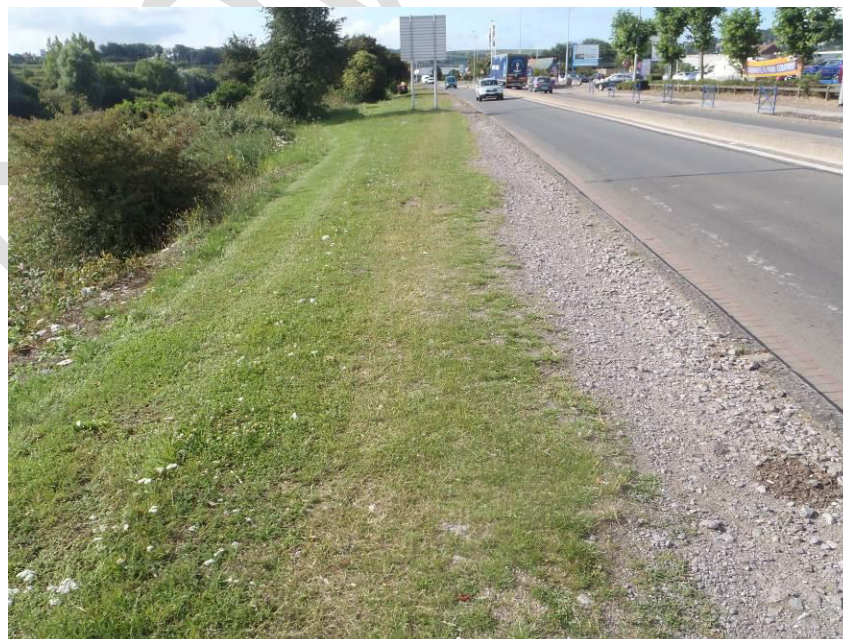
Photo 3 : Vue sur Accotement de la RD901
