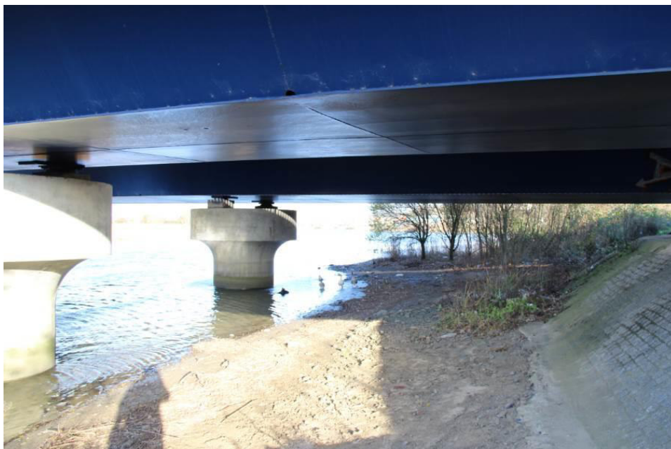
Photo 5 : Vue de la berge à aménager sous le pont Pitendal
