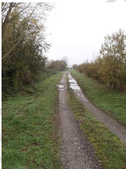
Photo 6 : Chemin longeant les bassins de tamponnement – Présence de nids de poule
