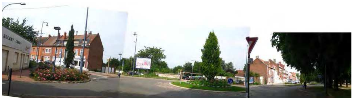
Vue du parking depuis la rue de Cambrai
