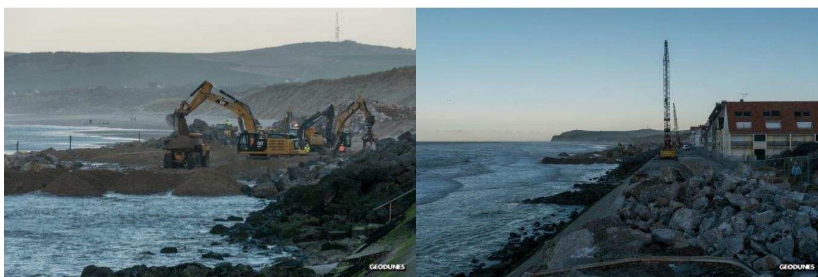
Figure 7 : Photographies des travaux de reconstruction du perré de Wissant (Source : Geodunes, 2015).
