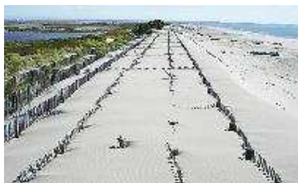
Figure 27 : Exemple de re-création d'un cordon dunaire à l'aide de ganivelles
