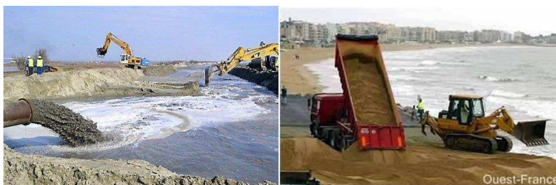
Figure 21 : Exemple de rechargement en sable au moyen d'une conduite (à gauche) ou par camions (à droite)
