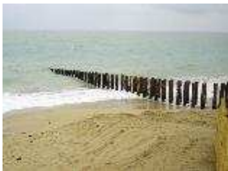
Figure 24 : Illustration photographique de pieux hydrauliques transversaux
