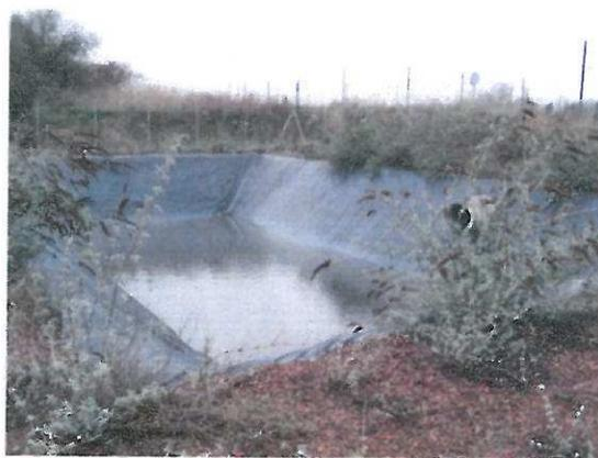
**PHOTO 12 : BASSIN DE RETENTION PRESENT AU NORD DE CETTE STATION CONSTITUANT LE REJET DU BASSIN VERSANT ROUTIER N°1**
