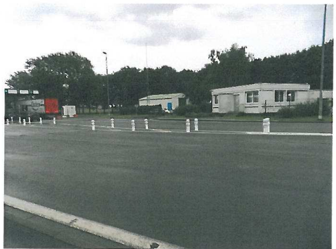
Bâtiments de la gare de péage
