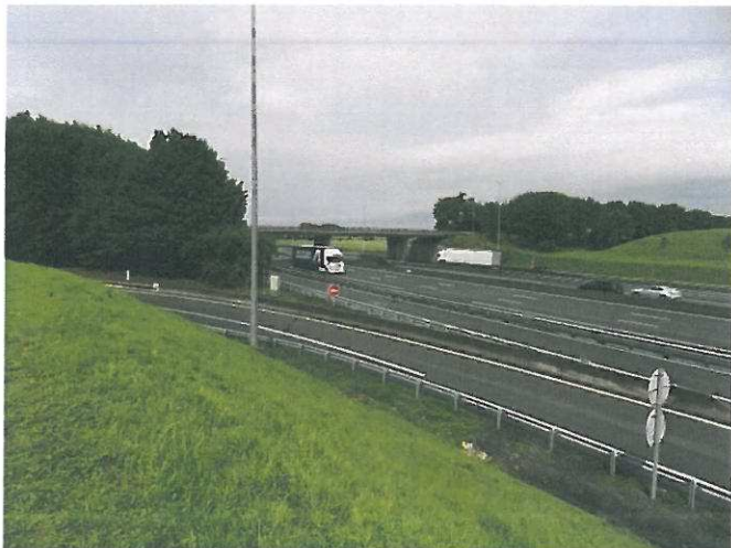
Vue de l'autoroute au niveau de la bretelle d'accès
