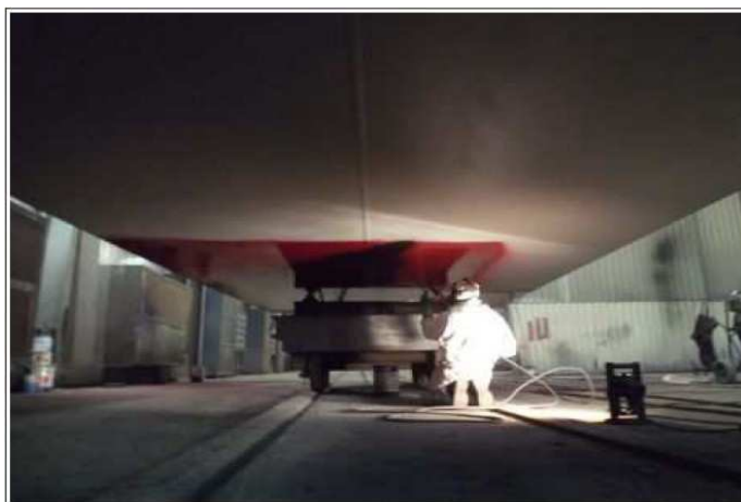
Construction des tronçons en usine
