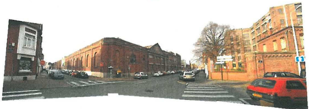
2 Vue depuis l'angle de la rue Jean Jaurès et de la rue Alain de Lille
