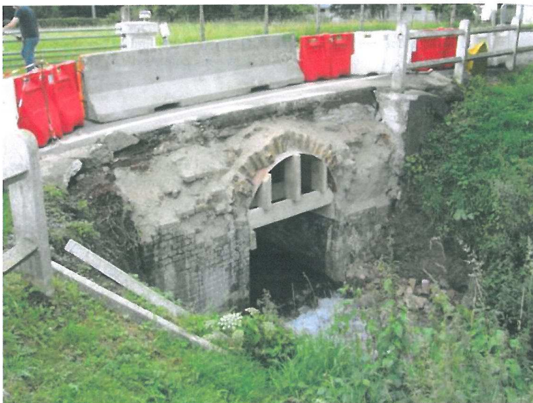
Vue aval de l'ouvrage existant après travaux de confortement provisoire
