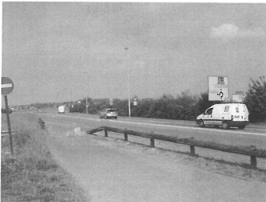
Commune de Beaurains (photo 02) Vue de la RD 60
