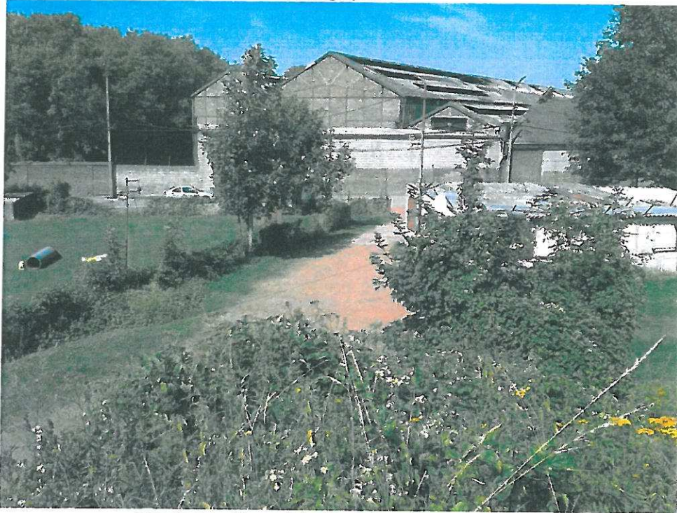
Vue de la partie nord du site et du voisinage (industrie)
