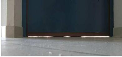
Jour sous la porte palière, défaut d'isolement acoustique entre le logement et la circulation
