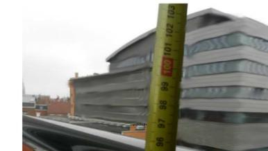
Hauteur du garde corps du balcon inférieure à 1m (rajout de dalles)
