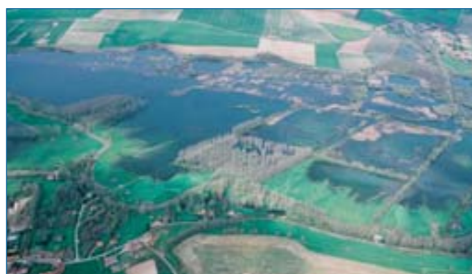
Les communes les plus touchées sont principalement celles situées à l'aval de Nampont.
