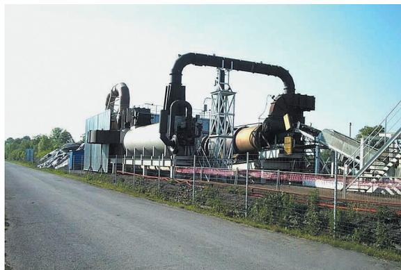
*Installation de traitement de sols pollués par désorption thermique sur le site de la cokerie d'Auby*
