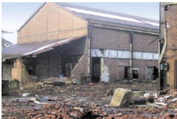
Intervention en urgence impérieuse pour la mise en sécurité du site de Vieux Condé Estampage (VCE) à Vieux Condé
