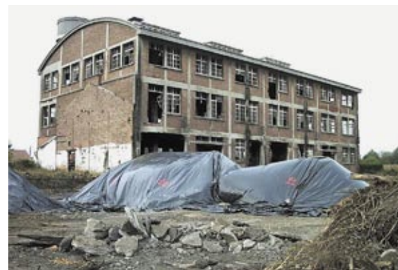
Site de Knox à Escaudain pendant les travaux de démolition
