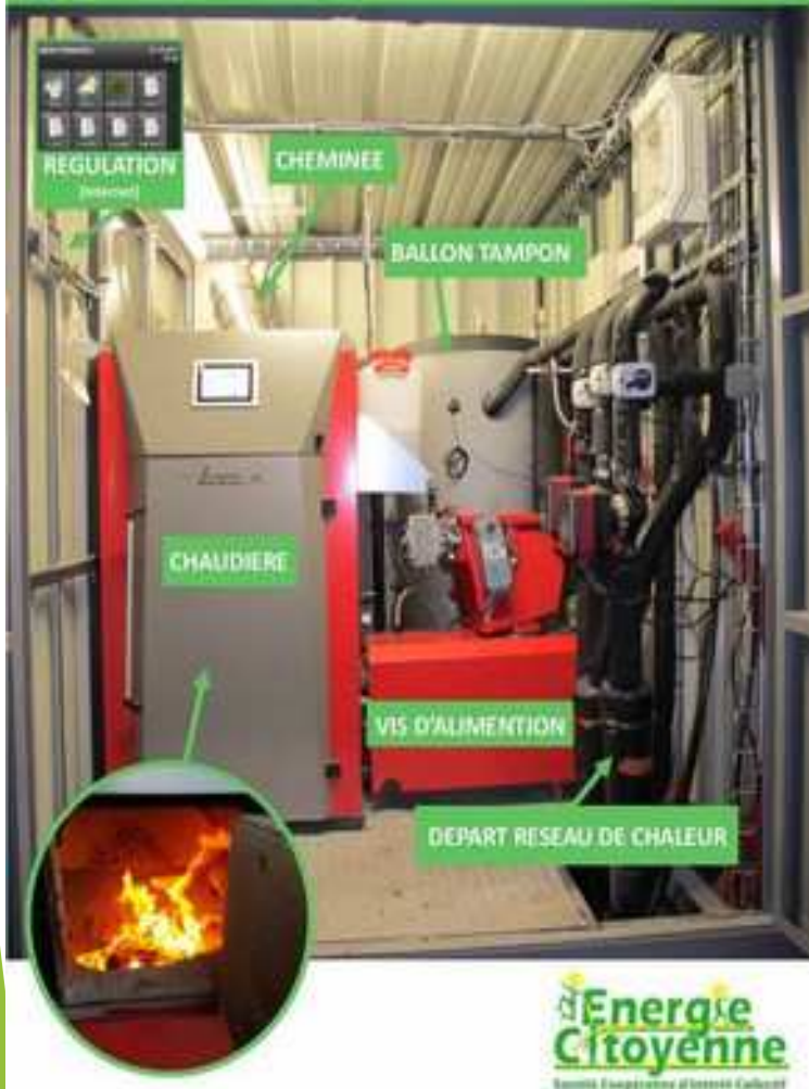
Micro-chaufferie collective au bois : LE LOCAL CHAUFFERIE
