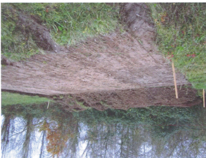
Exemple de décapage d'une zone d'accueil avec stockage des terres décapées © Thévenin OGE
