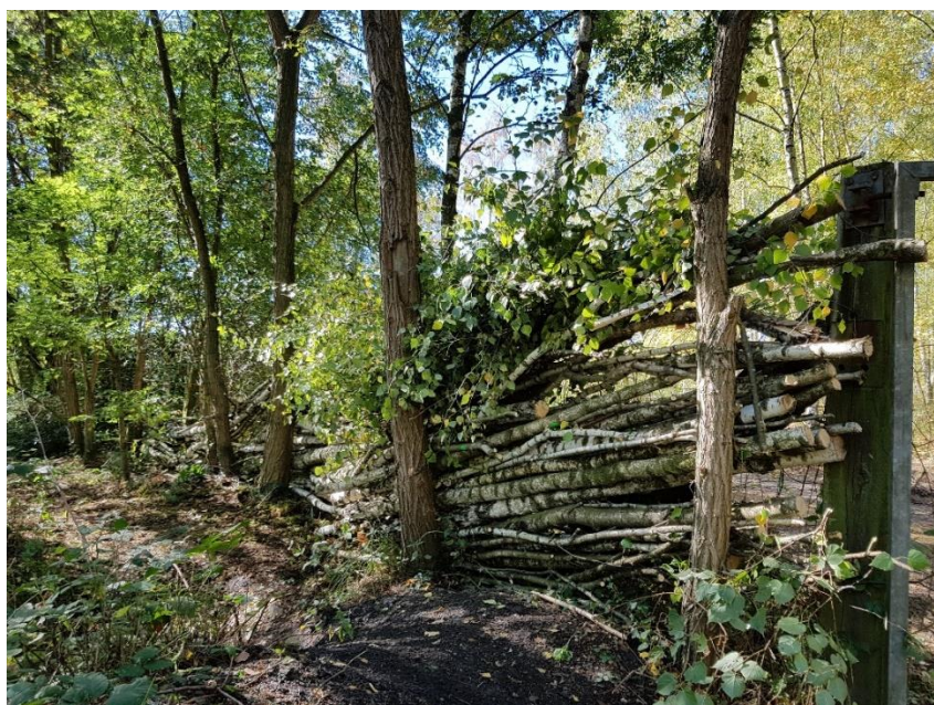
Travaux de confection d'une barrière végétalisée afin de mettre en défens des habitats
