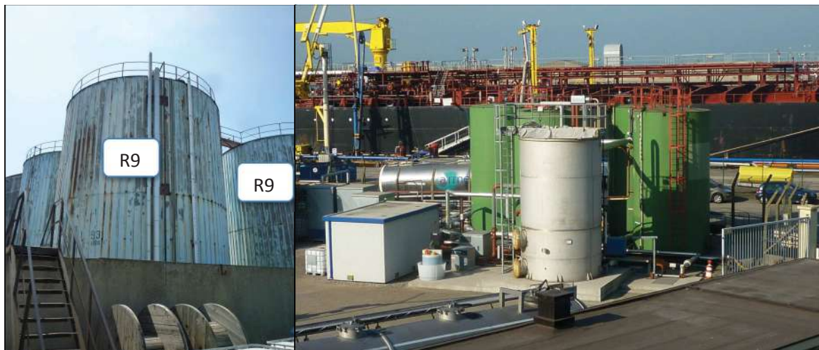
Figure 22 : Bacs tampons (gauche) et station de traitement des eaux (droite) (source : RTD)
