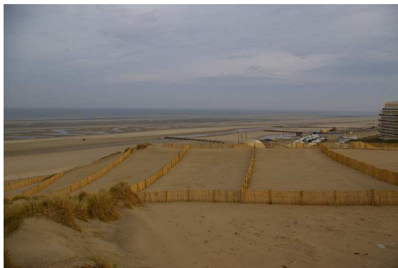
Travaux de fixation dunaire en FC de Merlimont
