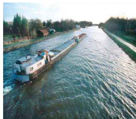
Le canal de la Sensée, à grand gabarit - Aubigny-au-Bac (Nord).
