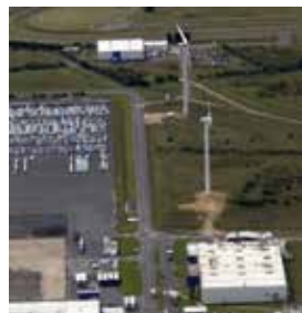
Développement en ponctuation - Usine Nissan - GB
