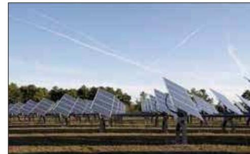
Figure 4 : Schéma de principe d'une installation-type photovoltaïque au sol (à gauche), et exemples d'installations sur support fixe en rangées (à droite, en haut) et sur support pivotant (à droite, en bas - tracker ©exosun).
