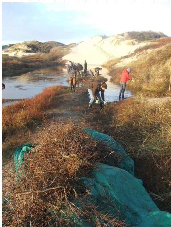
Chantier de restauration de panne dunaire
