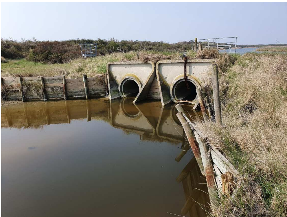
Figure 25 : Vanne de connexion à la mer
