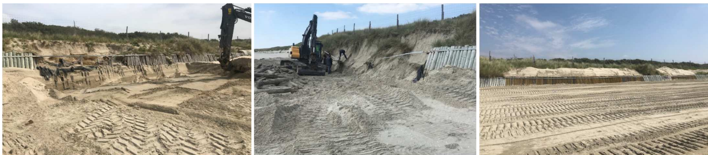
Figure 32 : Travaux de restauration pour changer les rondins de la digue de protection
