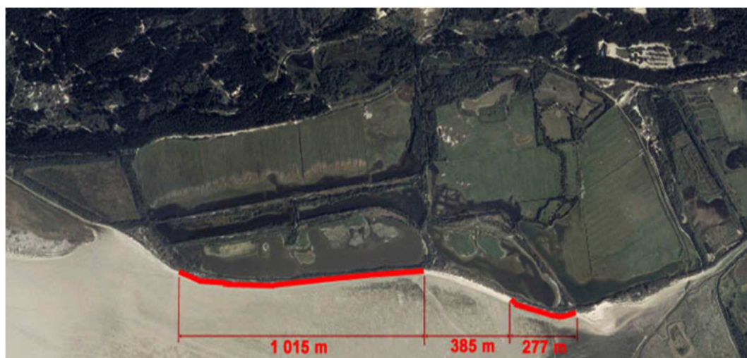
Figure 31 : Emplacement des ouvrages renforcés.
