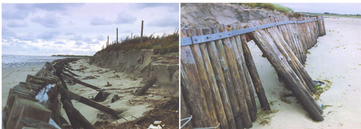
Figure 29 : Exemple de dégâts causés à la digue par des tempêtes (hiver 1992/1993)
