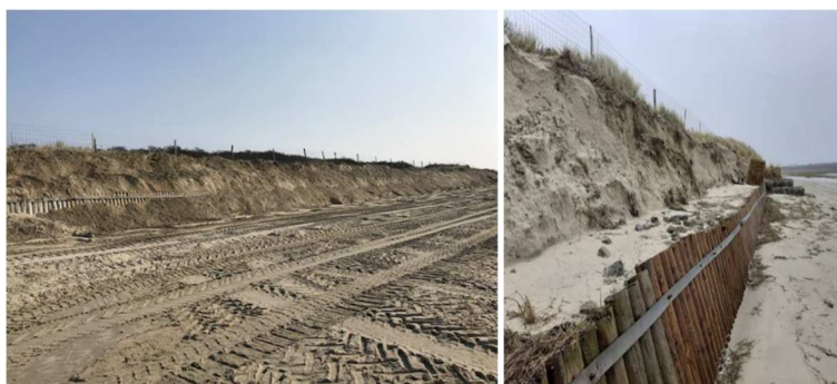
Figure 33 : Protection des zones en érosion à l'aide de ballots de foin et par des apports de sable prélevés
