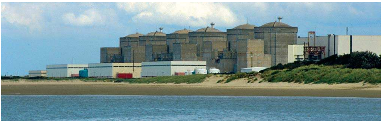
La centrale nucléaire de Gravelines.
