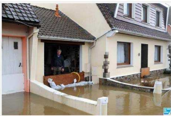
À Hesdignul le 2/11/2012. PHOTOS GUY DROLLET.
