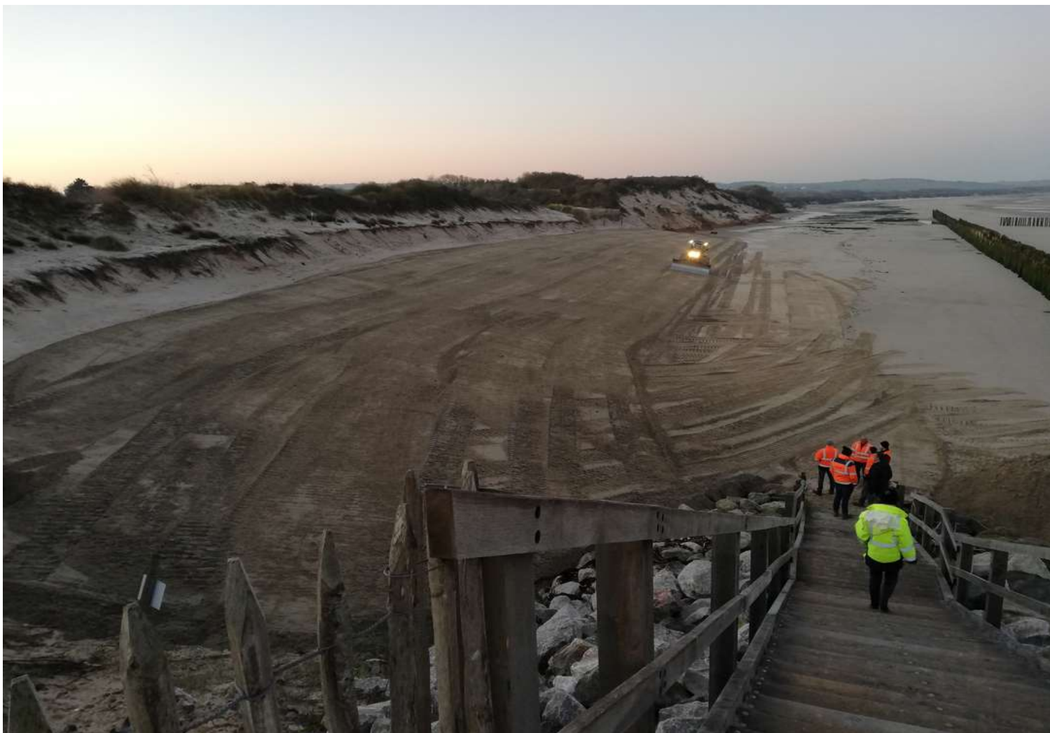
Rechargement de plage, Wissant, février 2020 (Photo PMCO)
