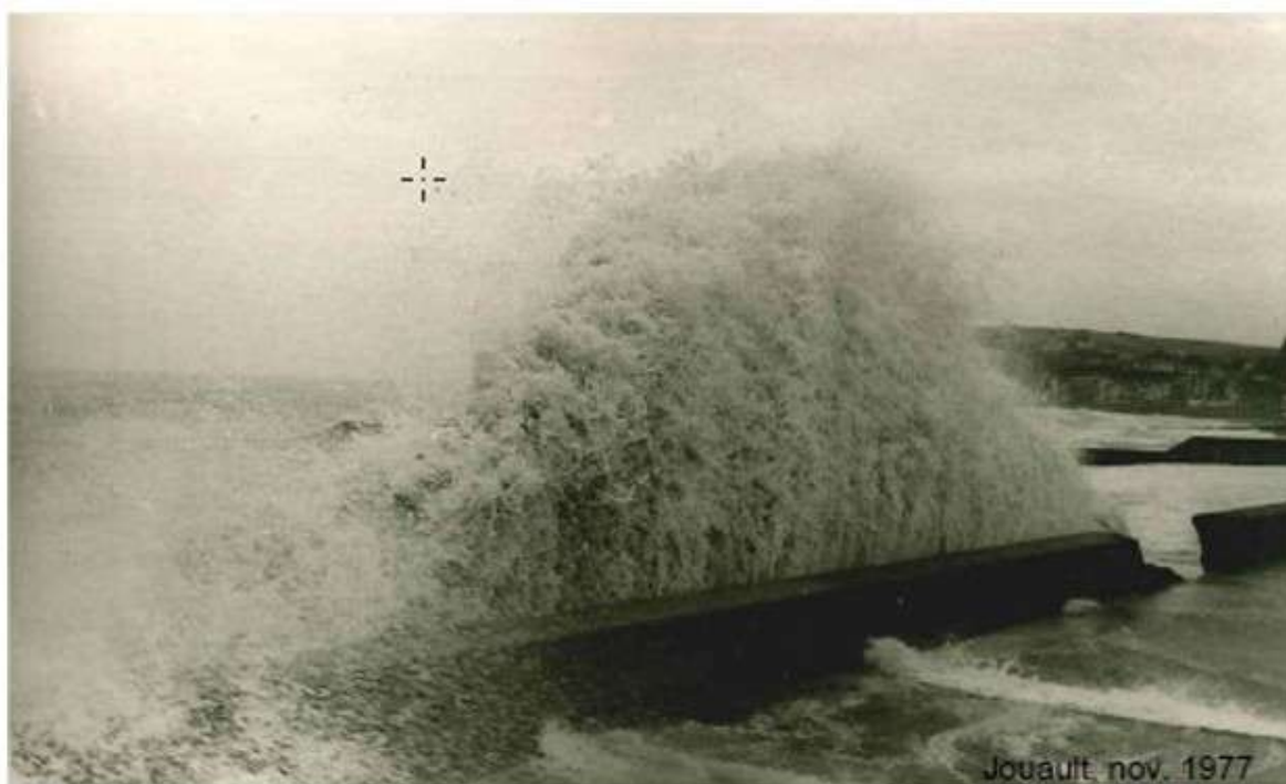
Figure 20 : Franchissements de la protection au droit de Mers-les-Bains/Le Tréport en novembre 1977 (source : PPRL Vallée de la Bresle)
