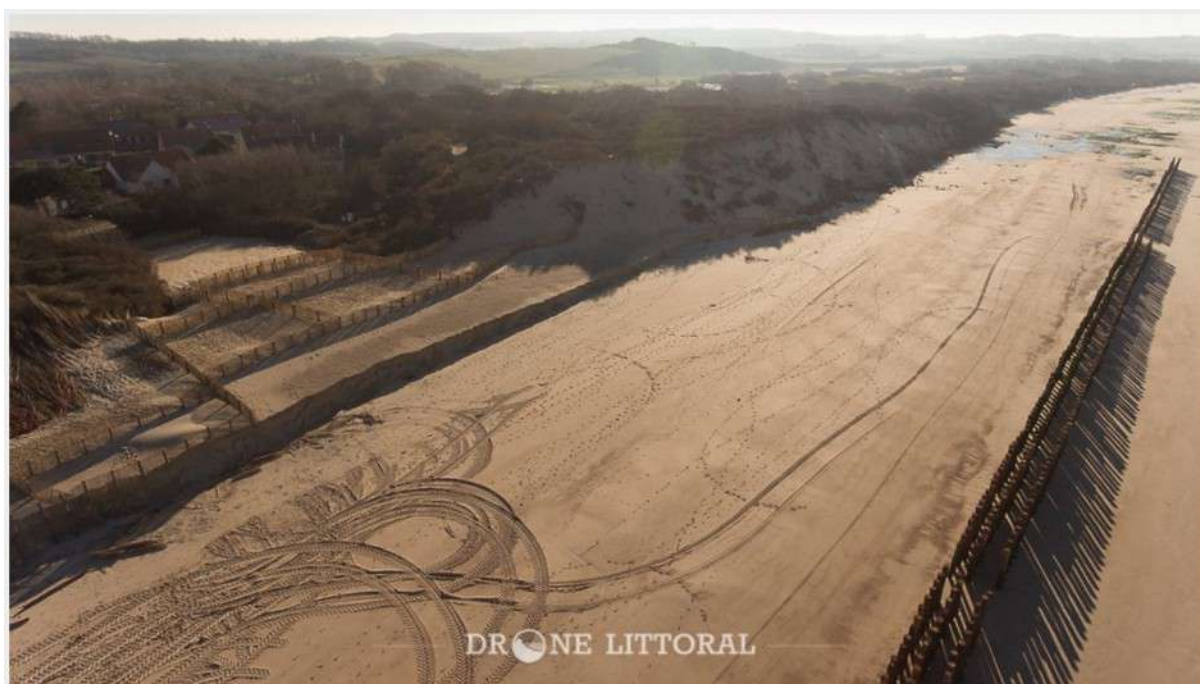
Figure 94 : Moyens utilisé afin de limiter l'érosion de la dune d'Aval (Wissant, 62) ; ganivelles, fascines, pieux bois (brise-lames) (source : Drone Littoral, 2017).
