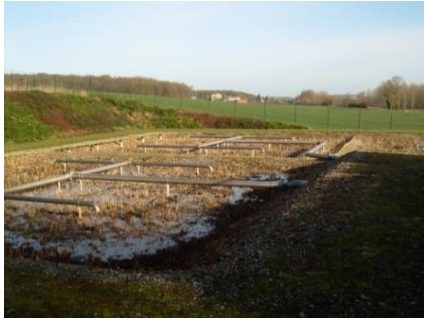
Station d'épuration à Cottency
