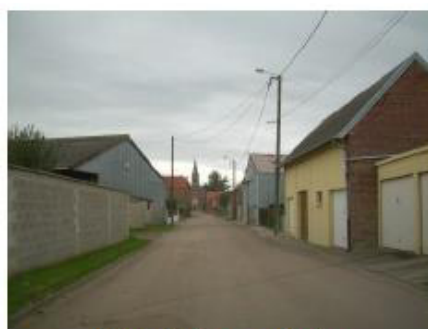
Ancien bâtiment agricole en brique réhabilité à Rouvrel
