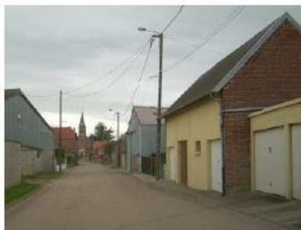
Ancien bâtiment agricole en briques réhabilité (enduit) à Rouvrel. L'usoir disparaît au profit d'un trottoir
