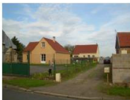
Constructions en double-rideau à Coullemelle
