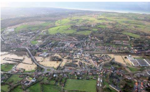
La Liane à Pont de Briques (27/11 - photo F. Bocquet)
