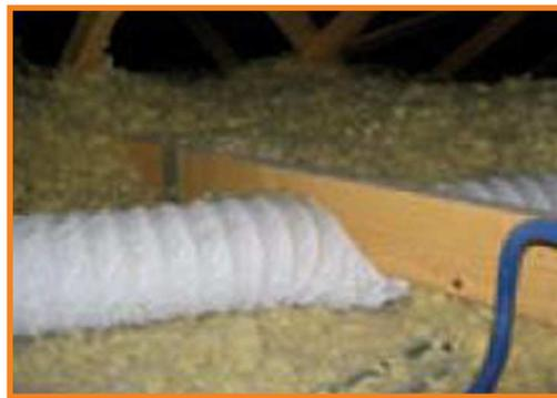
*Exemple de non conformité en rubrique Aération. Mauvaise mise en œuvre d'un flexible d'évacuation de l'extracteur limitant le renouvellement d'air.*
