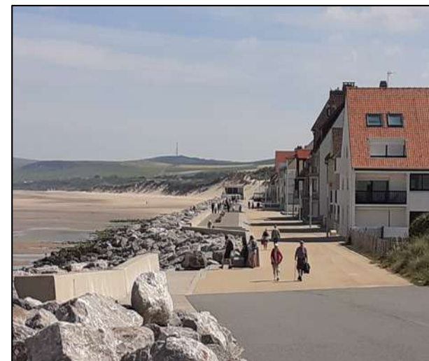
Consolidation pied de perré avec des amas rocheux : Wissant (62) 2022
