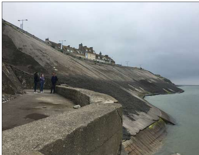
Perré et mur de soutènement – Le Portel (62) 2021
