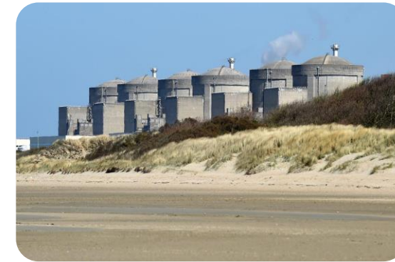
2 réacteurs nucléaires EPR Construction en 2027
