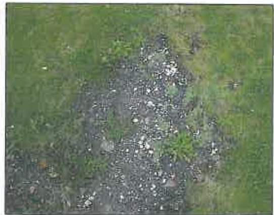
Figure 9 : Vue de l'accotement (terrill 43)
