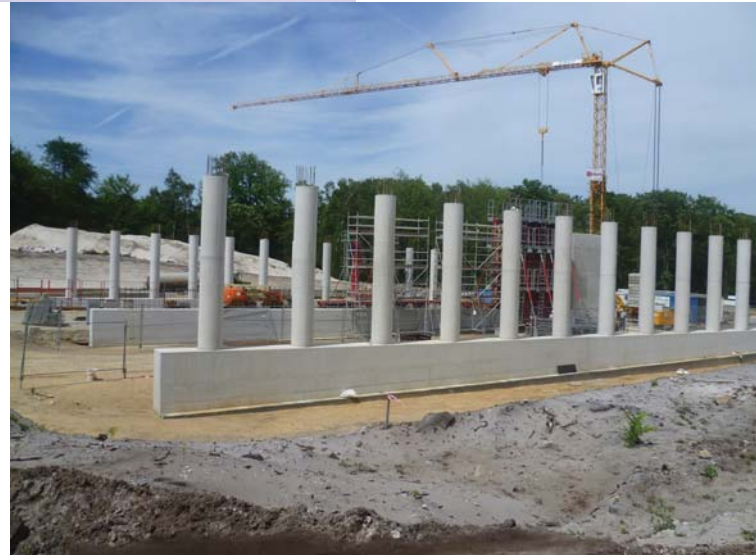
Passage faune de Tillet en construction
