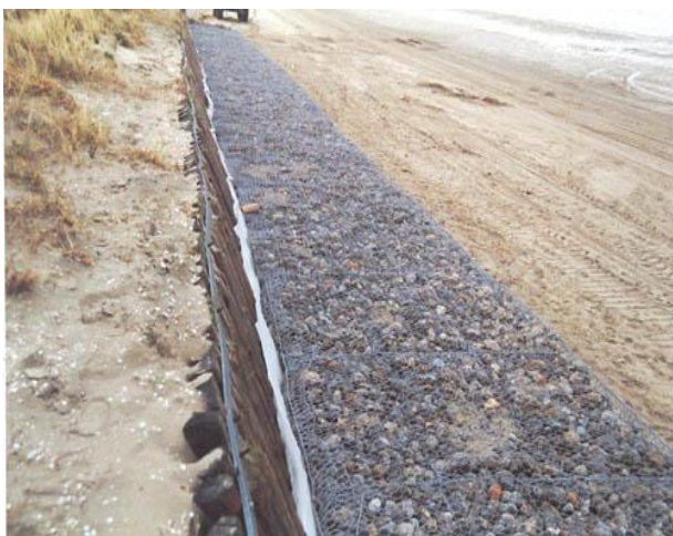
Figure 15 - Renforcement de la digue par des gabions de galets (1994). Une nouvelle opération de renforcement sera également effectuée en 2003 et 2006.
