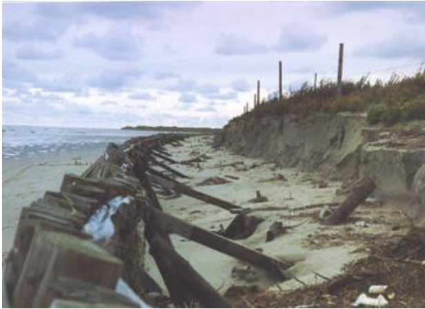
Figure 14 – Exemple de dégâts causés à la digue par des tempêtes (hiver 1992/1993)
