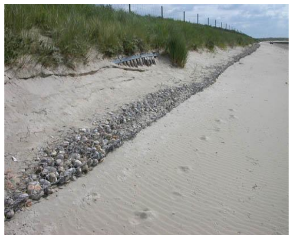
Figure 15 - Renforcement de la digue par des gabions de galets (1994). Une nouvelle opération de renforcement sera également effectuée en 2003 et 2006.
