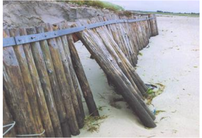
Figure 14 – Exemple de dégâts causés à la digue par des tempêtes (hiver 1992/1993)
