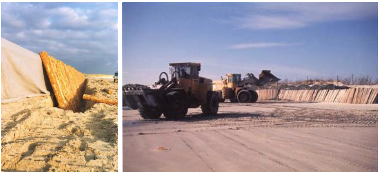
Figure 13 - Pose de rondins de pins en renforcement de la digue de sable.
