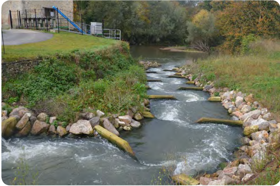
Bras de contournement avec pré-seuils à Mourlinghen (62)
