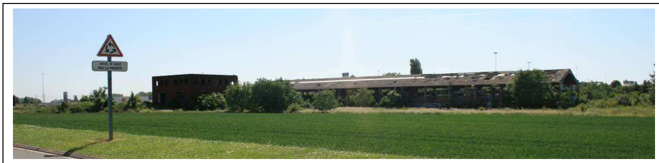
Photographie 28. Bâtiments en friche au niveau du même secteur
