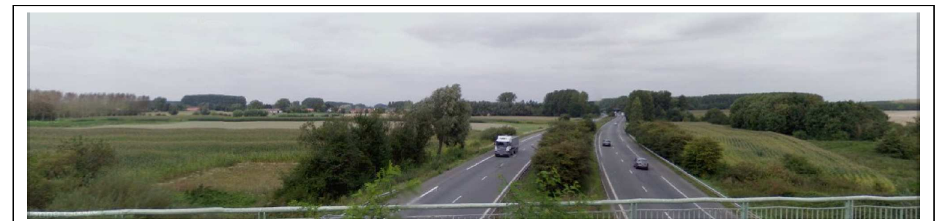
Photographie 41. L'autoroute A23 au niveau de son passage entre Genech et Templeuve
