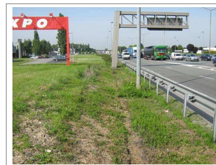
Photographie 1. Accotement de l'A1 sans fossé, contre la zone d'activité de l'Épinette
