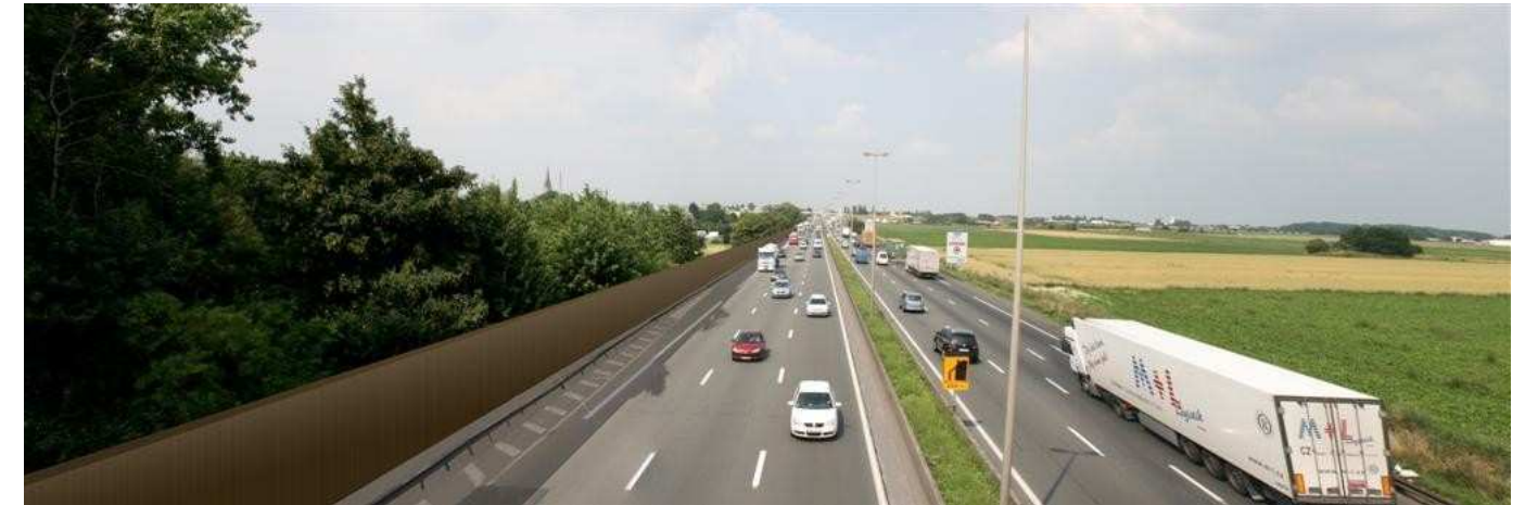
Insertion du mur antibruit de Vendeville
