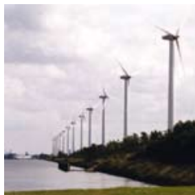
Développement en structuration - Canal de Zeebrugge (Belgique)
