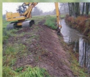
Restaurer des sections d'écoulement adaptées demeure une priorité. Celle-ci passe par la suppression des merlons et le retalutage des rives en pente douce ou encore le faucardage limité au centre du chenal.
