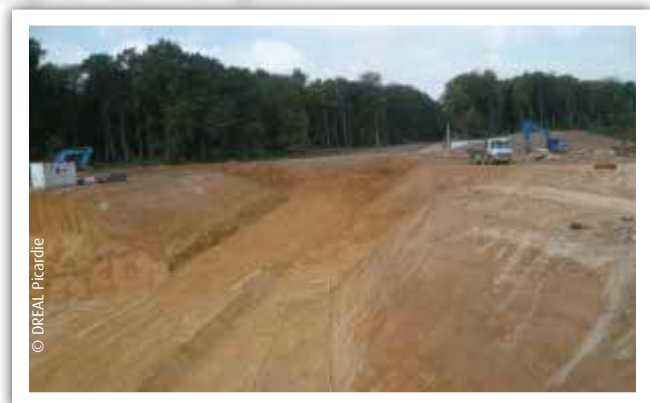
Diffuseur RD2 à Montgobert
