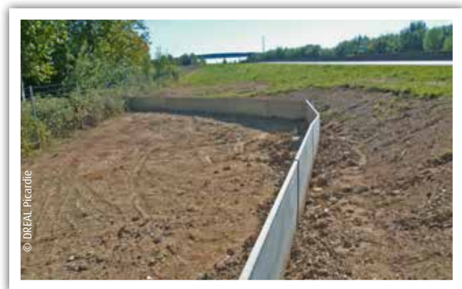
Travaux d'aménagement pour la préservation des batraciens sur la RN 31 Beauvais. Quelques adaptations des aménagements déjà en place sur la déviation, afin de favoriser le développement des populations d'amphibiens et de petite faune présentes, ont été réalisées à l'été 2014 par les équipes spécialisées «travaux» de la DIR Nord.
