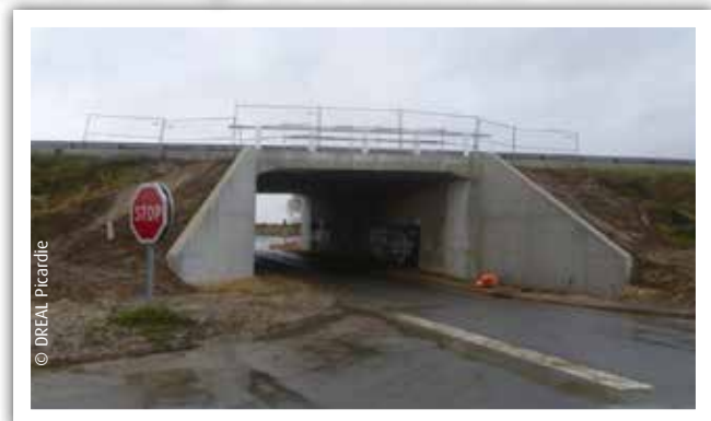
Élargissement de l'ouvrage de la sucrerie de Vauciennes
