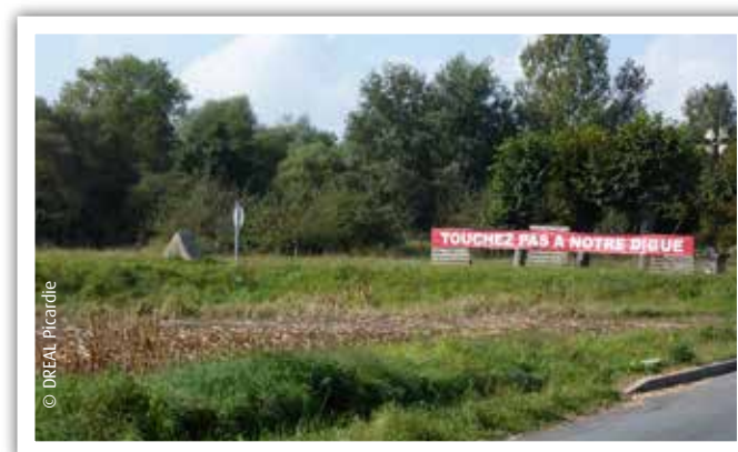
Digue de Varesnes
