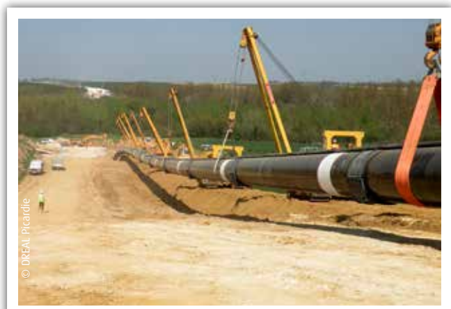
Construction de la canalisation de transport de gaz «Arc de Dierrey»
