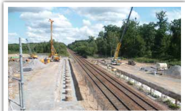
Premiers travaux de franchissement de la ligne Paris-Laon-Maubeuge
