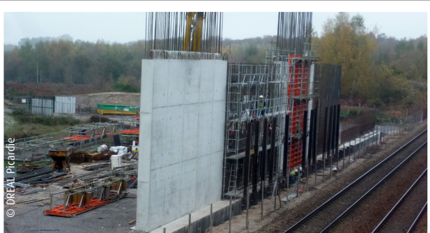
Ouvrage de franchissement de la voie ferrée Paris-Laon-Maubeuge
