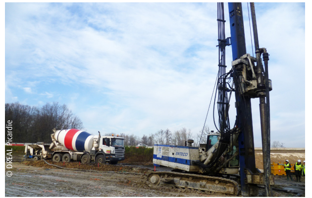
Travaux de l'échangeur de Frocourt
