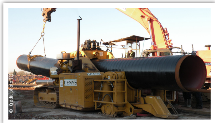
Surveillance des opérations de cintrage des tubes sur le chantier des Hauts de France II
