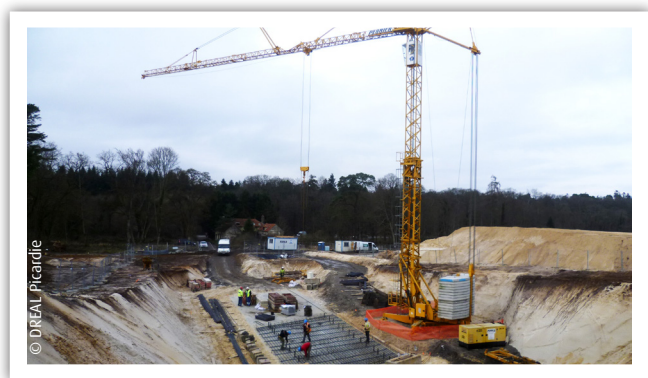
Travaux de la déviation de Gondreville
