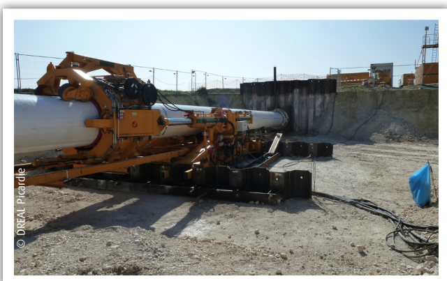
Traversée en forage dirigé sous la rivière Somme et le marais attenant à proximité de Corbie (80)
