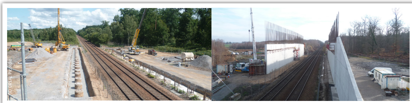
Avancement des travaux de la déviation de Vaumoise (60)
