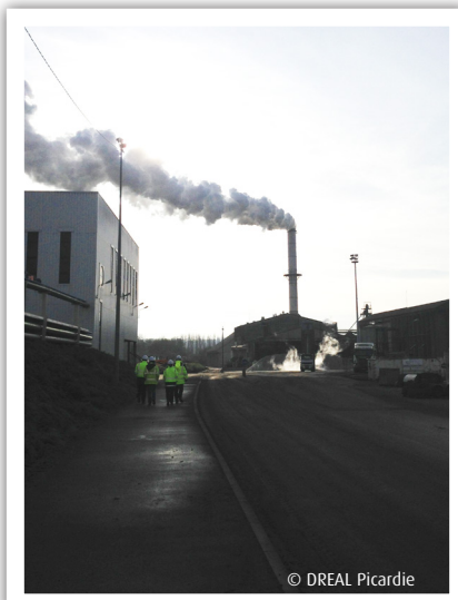
Cheminée des installations de déshydratation de la sucrerie TEREOS de Bucy le Long
