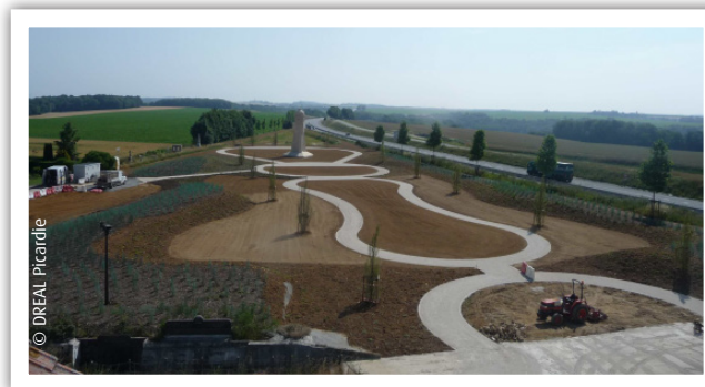
Aménagement de l'aire du moulin de Laffaux sur la RN 2
