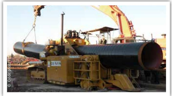
Surveillance des opérations de cintrage des tubes sur le chantier des Hauts de France II
