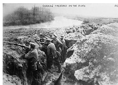
Une tranchée allemande
