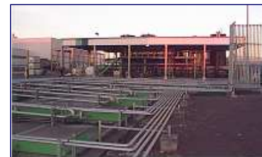
Solvants en cuves enterrées
