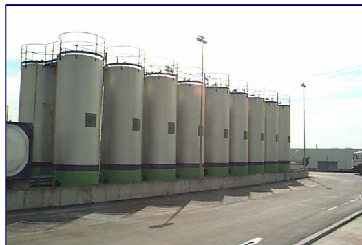
Solvants en cuves hors sol
