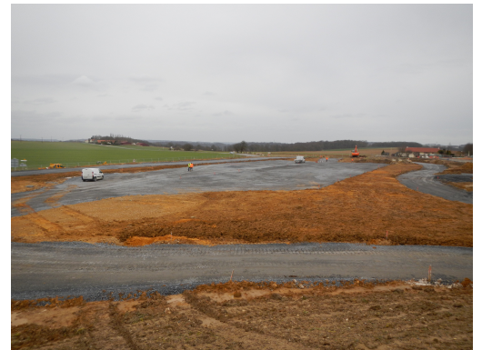
Réalisation du parking poids lourds
