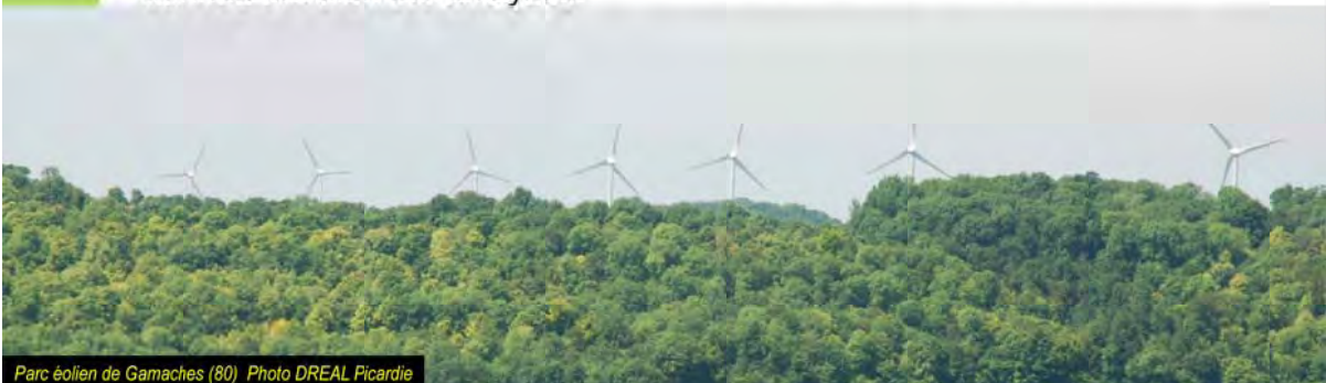
Parc éolien de Gamaches (80) Photo DREAL Picardie
